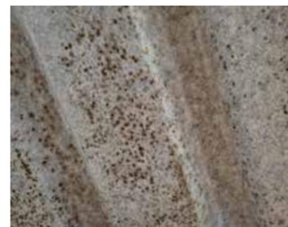
Vliesbeschichtung mit Schimmelbildung durch unzureichende Lüftung (Beispiel)
