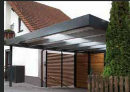
» **Transparente Einzel-Dachbahnen:** Bei einer teilweisen Lichtdurchlässigkeit wird zum Beispiel nur die mittlere Dachbahn gegen eine transparente Eindeckung getauscht. Bei einzelnen transparenten Dachbahnen müssen immer links und rechts normale Dachbahnen als Auflage vorhanden sein
