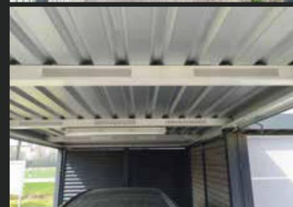
» **Pfettenverkleidung:** Die Verkleidung der Pfetten bietet eine geschlosseneren Optik. Wahlweise kann die Verkleidung durchgehend oder mit einer Quadratlochung geliefert werden. Die Lackierung ist in beinahe allen RAL-Farben wählbar
